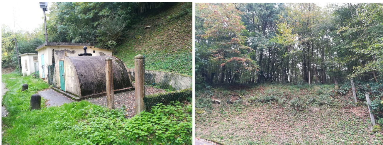
Figure 14 : clôture du captage.
