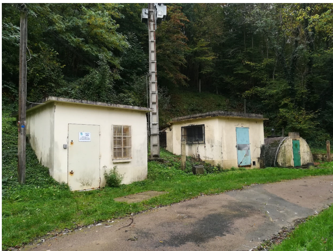
Figure 25 : vue des installations de captage.
